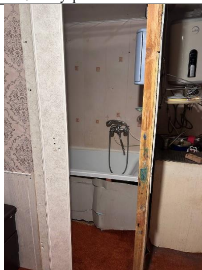
Фото № 12 – Внутреннее состояние помещения
