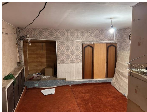
Фото № 8 – Внутреннее состояние помещения
